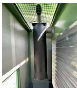
Industrie-Schalldämpfer innenliegend sowie elektrische Abluftklappe serienmäßig
