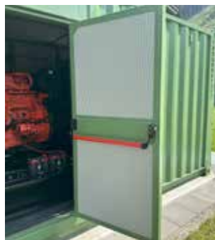
Große Zugangstür auf beiden Längsseiten mit Panikbeschlag
